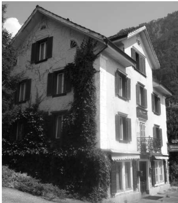
DAS EHEMALIGE GASTHAUS KRONE IST EIN TYPISCHES ZIMMERMEISTERHAUS. ÜBER DEM HAUPTINGANG IST EIN BALKON MIT SCHMIEDEEISERNER BRÜSTUNG ANGEBRACHT.
