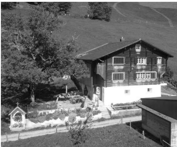
DAS HAUS TANNEN 5 BILDET ZUSAMMEN MIT DEM BILDSTOCK EIN BEDEUTENDES BAUENSEMBLE AUS DEM 17. JAHRHUNDERT. IN JÜNGSTER ZEIT WURDE DAS GEBÄUDE MEHRFACH UM- UND AUSGEBAUT. FOTO: MICHAEL TOMASCHETT, SCHWYZ
