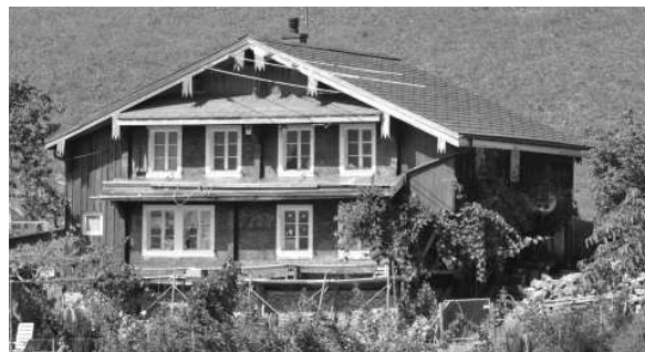
DAS HAUS UNTER WILGIS MIT DEN MARKANTEN KLEBDÄCHERN AN DER TALSEITIGEN HAUPTFASSADE STAMMT VERMUTLICH AUS DEM 18. JAHRHUNDERT. FOTO: KLAUS PICHLER, LACHEN.
