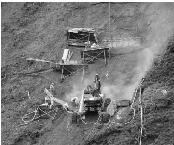
ARBEITEN AM FUNDAMENT DER BRÜCKE IM STEILHANG BEI DER TALSTATION
