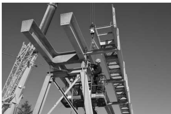
MONTAGEARBEITEN AN DER BRÜCKE BEI DER BERGSTATION
