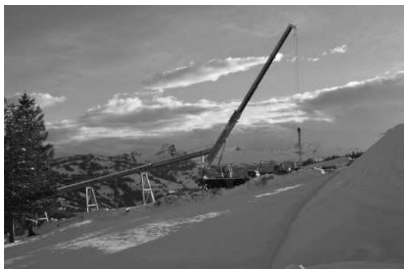
BRÜCKE BEI DER BERGSTATION
