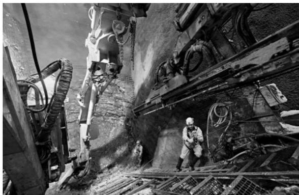
DIE ARBEITEN IM STEILEN GELÄNDE DES MITTLEREN TUNNELS SIND SEHR ANSPRUCHSVOLL. AUS DIESEM GRUND MÜSSEN ALLE ARBEITER IMMER GESICHERT SEIN.
