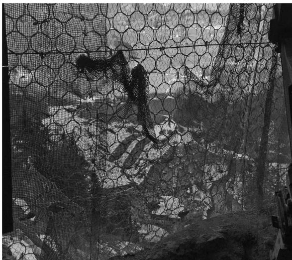
BILD (IMPLENIA): BLICK AUF DIE TALSTATION AUS DEM TUNNEL-PORTAL DES UNTERSTEN TUNNELS. DIE LETZTEN TUNNELMETER WERDEN MIT VORSICHTIGEN SPITZARBEITEN AUSGEFÜHRT, UM DAS DARUNTER LIEGENDE TRASSE NICHT ZU BESCHÄDIGEN.
