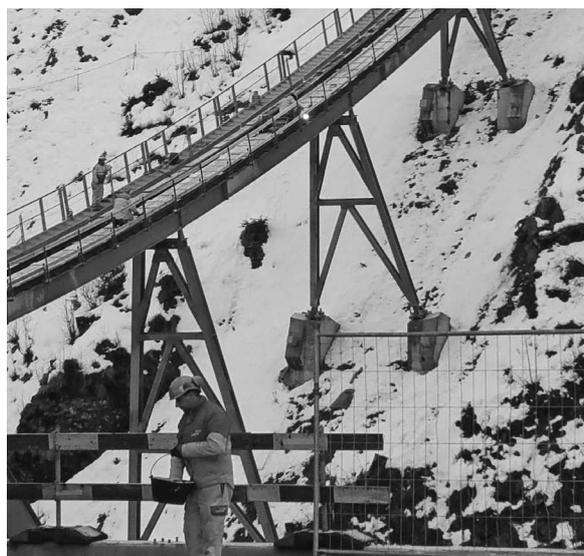
BILD: AUF DER BRÜCKE ÜBER DIE MUOTA BEI DER TALSTATION WERDEN SCHWEISSARBEITEN AN DEN SCHIENEN AUSGEFÜHRT
