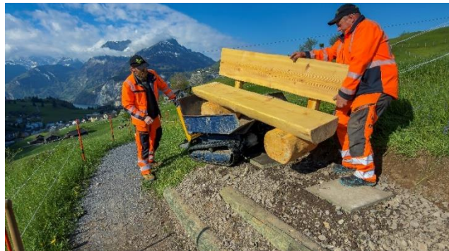
Die Mitarbeiter des Werkdienst beim Setzen des Banks. Bild: Ernst Immoos
