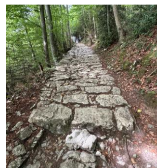
Abb. 4, Beginn der ca. 40m langen Wegstrecke mit hist. Bausubstanz.
