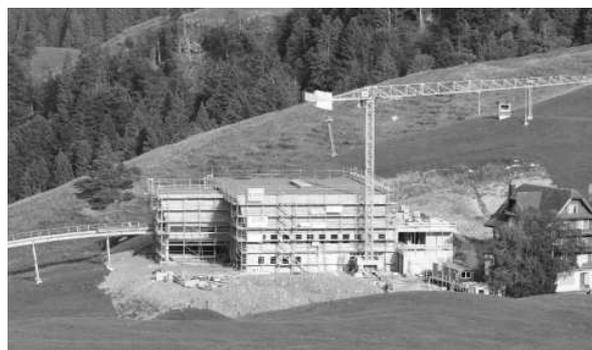
DAS GEBÄUDE DER BERGSTATION HAT SEINE DEFINITIVE HÖHE ERREICHT. DER OBERSTE STOCK BESTEHT AUS EINER METALLKONSTRUKTION MIT HOLZHÜLLE.
