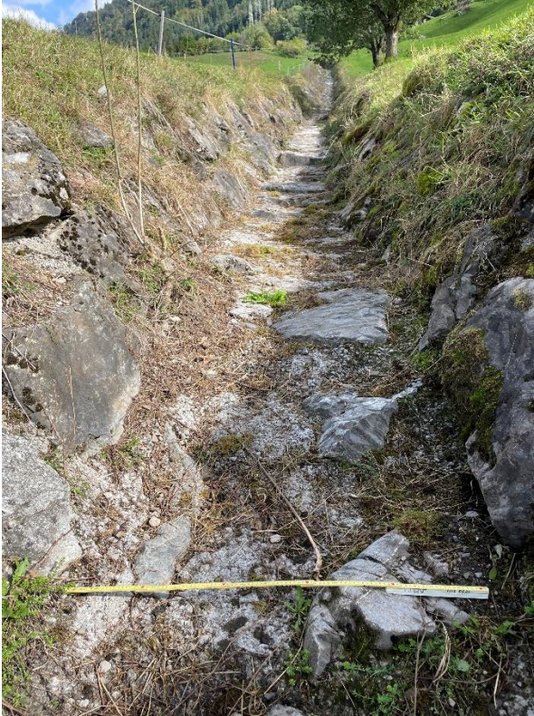
Abb. 8: Erhebung aktueller Sohlenbreite (Foto R+K, 04.10.2023)
