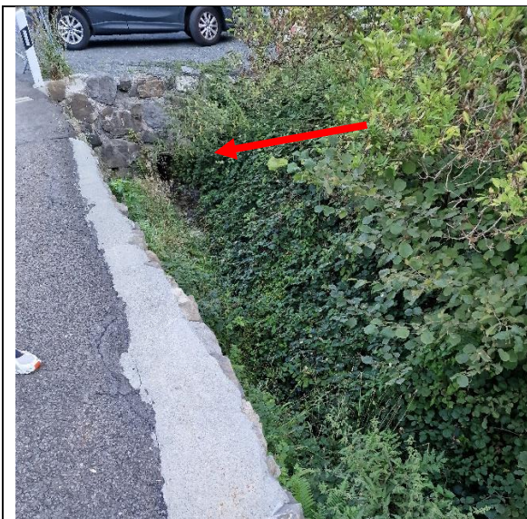
Abb. 11: Abschnitt 3 bachabwärts, Einlauf in Eindolung (R+K, 11.09.2023)
