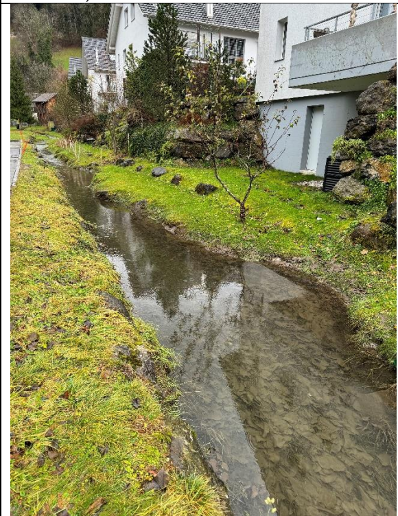
Abb. 17: Abschnitt 4.3 Foto bachaufwärts, nach Starkregen, (Parz. 777) (Gemeinde Morschach, 14.12.2023)
