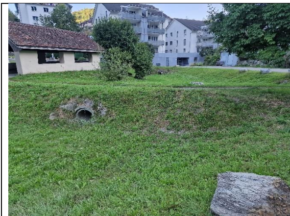
Abb. 23: Abschnitt 6 Retentionsbecken (R+K 11.09.2023)
